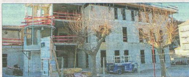
Le chantier de l'espace culturel a été réparti sur plusieurs exercices budgétaires.
